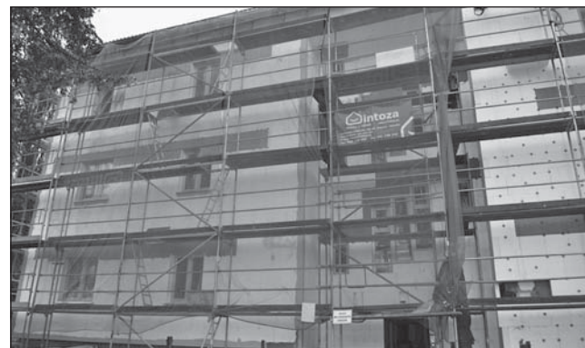
Rekonstrukce domu probíhá podle harmonogramu. Po kolaudaci bude k dispozici 12 bytových jednotek.
